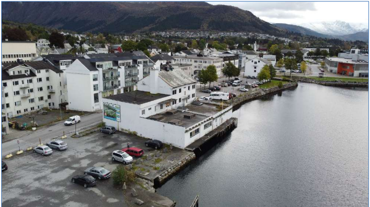
Figur 2.14.3 Fasade mot sjø og vest
