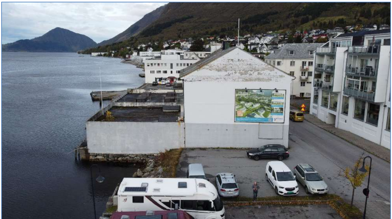
Figur 2.14.4 Fasade mot aust
