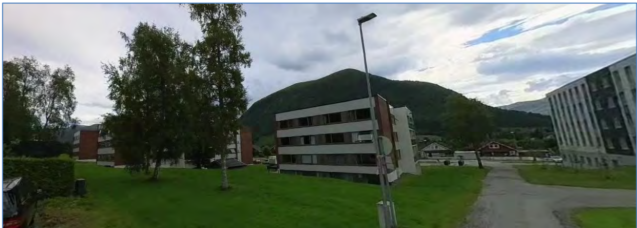
Figur 2.14.4 Planområdet sett frå nord-vest (Google Streetview) med Grønbakken nedover mot Vikebygdvegen og den nyare blokka i høgre biletkant. Blokka som skal sanerast ligg til venstre for Grønbakken.
